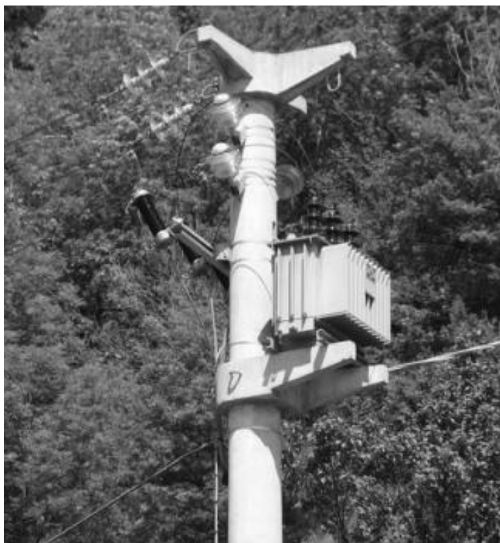
Fig. 34 - Trasformatore MT/BT installato su palo con raffreddamento in olio
