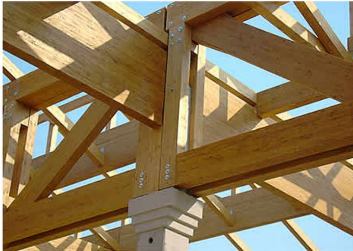
Figura 7 Travi in legno lamellare
