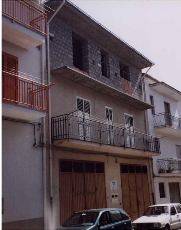
Figura 36 - Esempio di fabbricato sopraelevato
