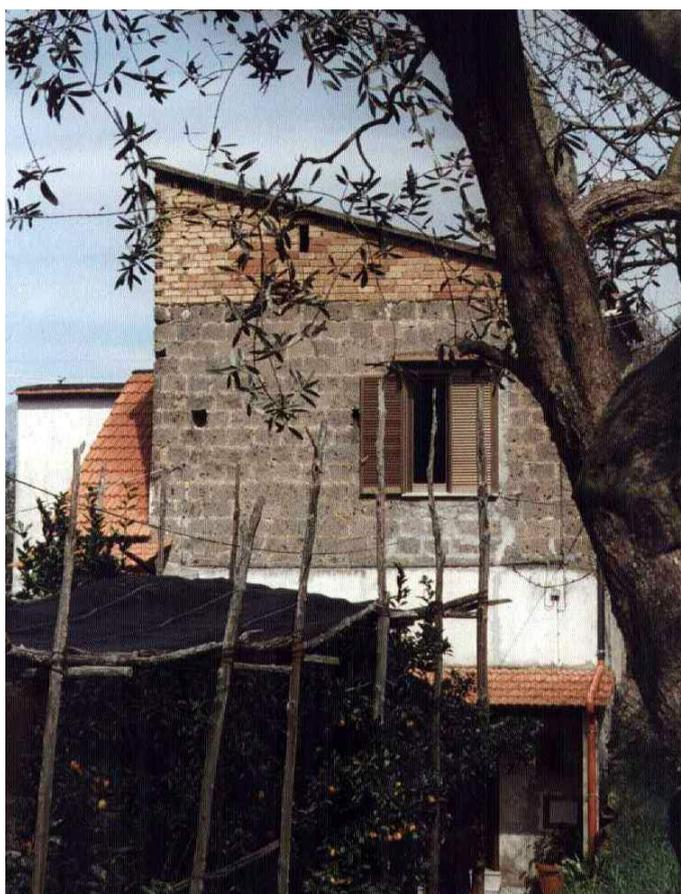
Figura 35 - Esempio di fabbricato sopraelevato
