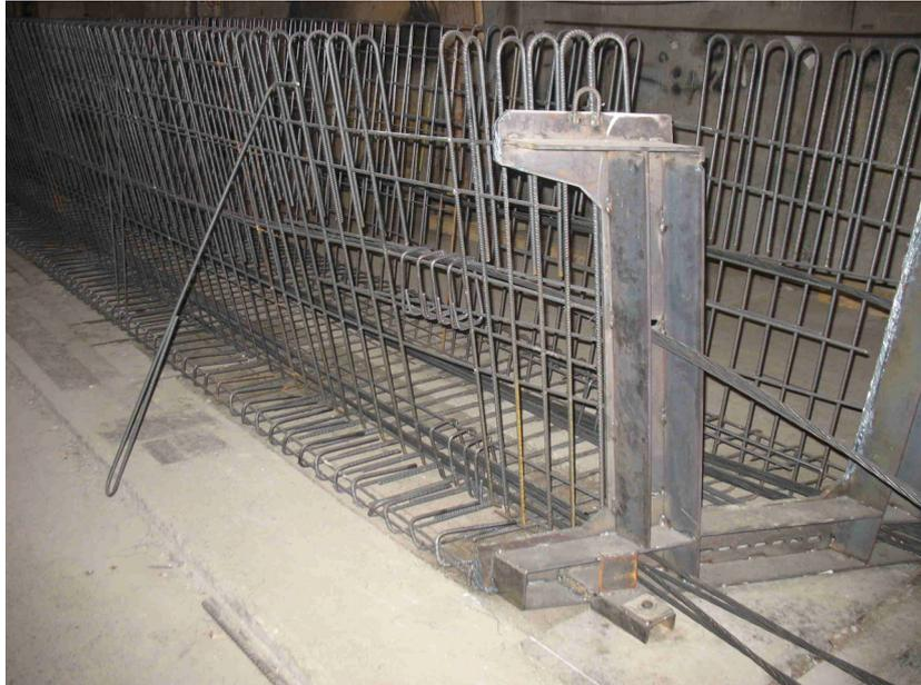
Figura 31 - L'armatura lenta di un tegolo in c.a.p.
