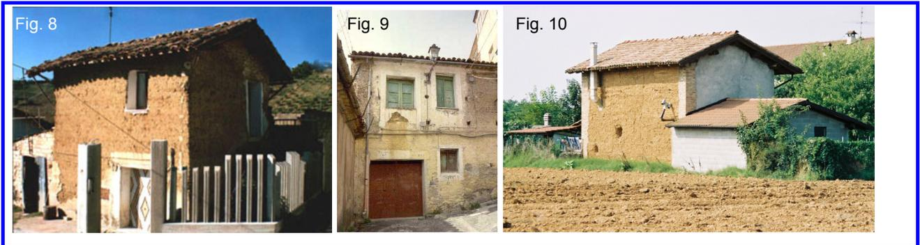
Fig. 8 - Edificio di terra nel centro della cittadina di Casalcontrada, in provincia di Chieti, Italia;
