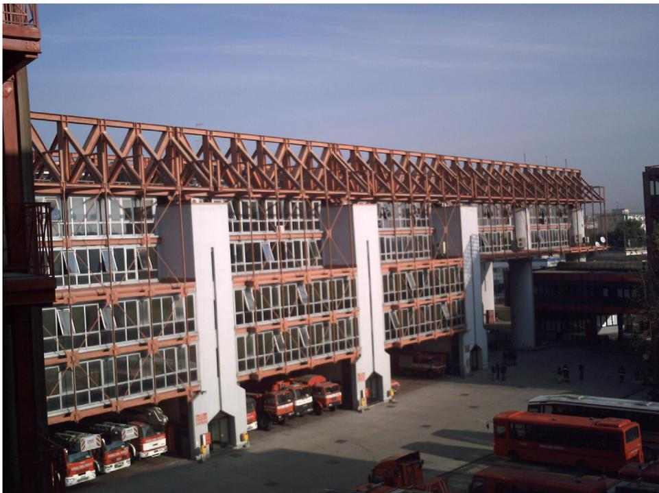
L'edificio "A" (mensa) presenta uno schema costruttivo costituito da una pianta rettangolare allungata larga circa 25 m e scandita in senso longitudinale secondo un modulo di tre metri. Si accoppiano in senso trasversale due nuclei in cemento armato con sezione a C, che contengono le scale ed ascensori. Le varie coppie di nuclei sono poste ad interasse di 18 m in senso longitudinale. Ciascun nucleo è inscritto in un rettangolo di dimensioni 3x6 mxm.
